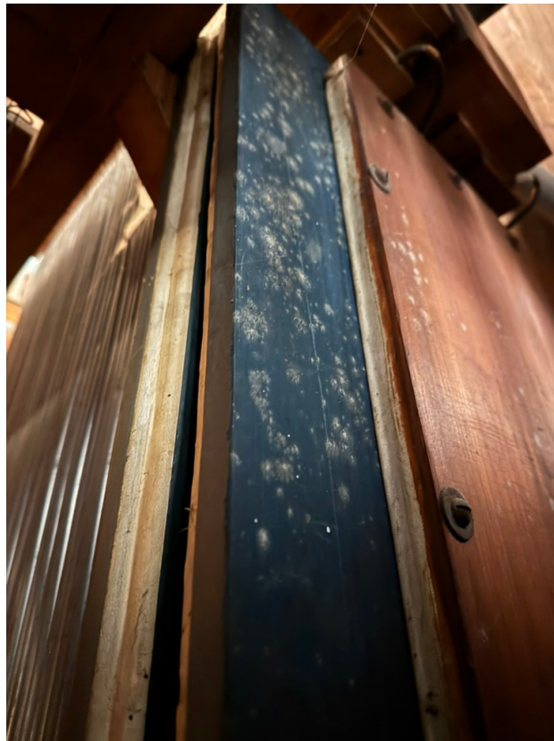
Schimmelbefall am Stoßfänger-Balg
